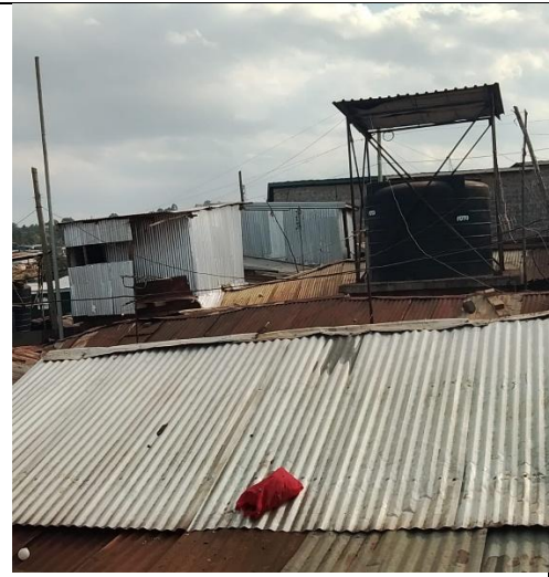
Voorbeeld golfplatendak en watertank
